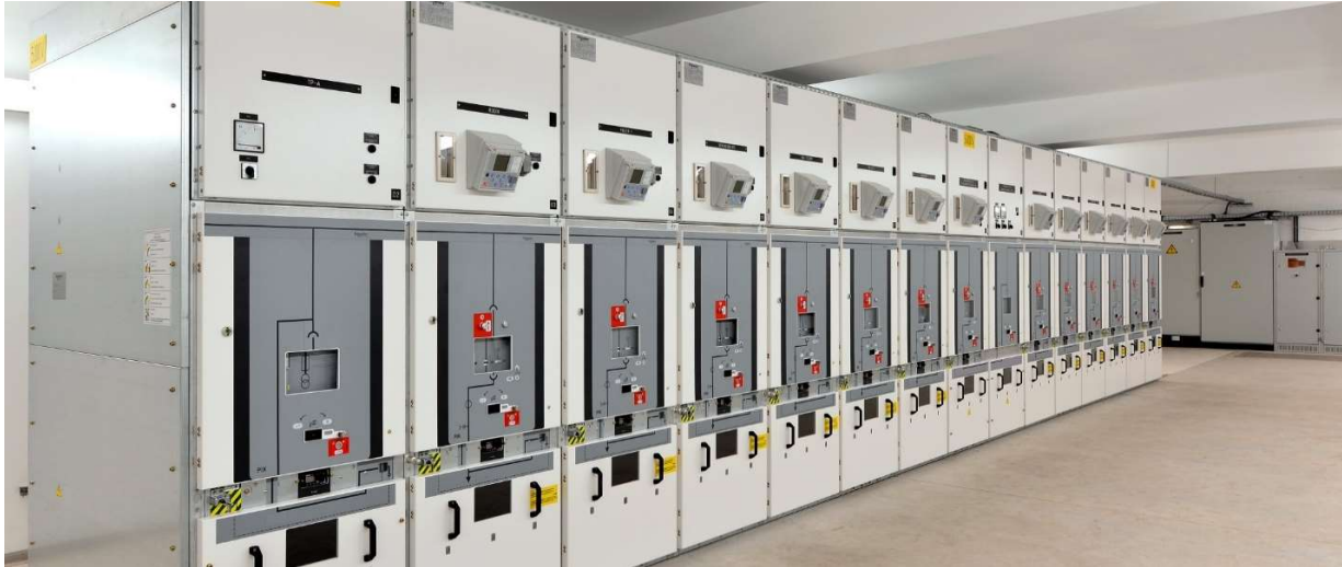
Figure 14 : Tableau haute tension dans un poste de fourniture Sibelga
